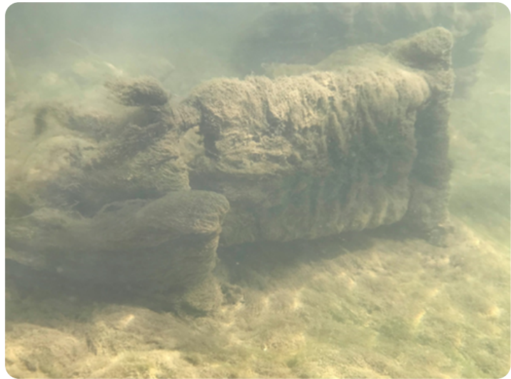
Abbildung 17: Lochplatte mit starkem Biofilmbewuchs.
