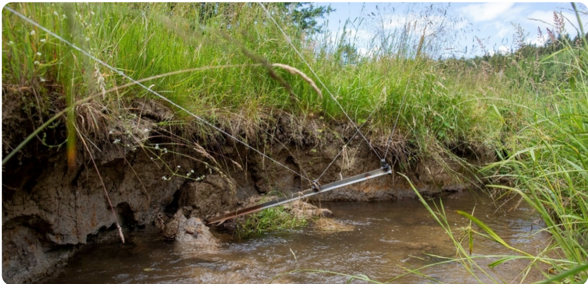
Abbildung 27: Ufererosion am [REDACTED].
