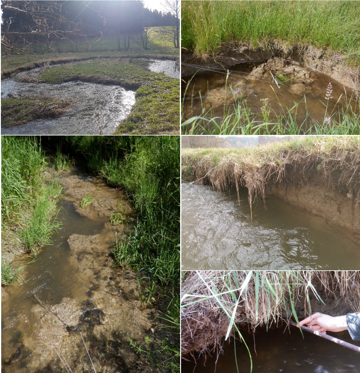
Abbildung 2 : oben-links: Prallhang in der gesamten Außenkurve eines Mäanders bei hohem Wasserstand, oben rechts: Abbruch im selben Mäander wie oben-links und hereingebrochener Weidezaun, unten-links: Gewässerbett beinahe vollständig mit Lehm überlagert aufgrund von Abbruch und der Verlagerung des Bachbetts, mitte-rechts: herunterhängender Grassoden, unten-rechts: ca. 40cm tief unterspülte hohe Abbruchkante mit Grassoden
